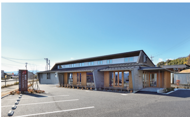
建設地:飯田市上郷黒田779-1 構造規模:木造1階建て、延べ335.57㎡ 竣工:2023年12月
